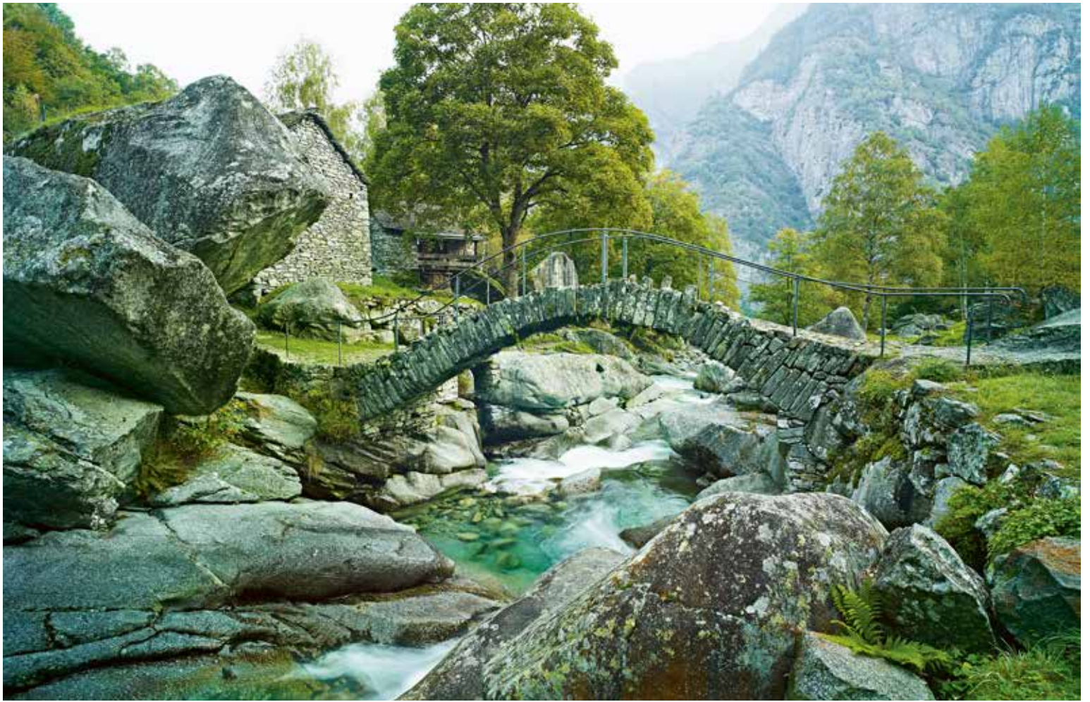
Brücke Puntid bei Foroglio, Val Calnègia, Tessin.
